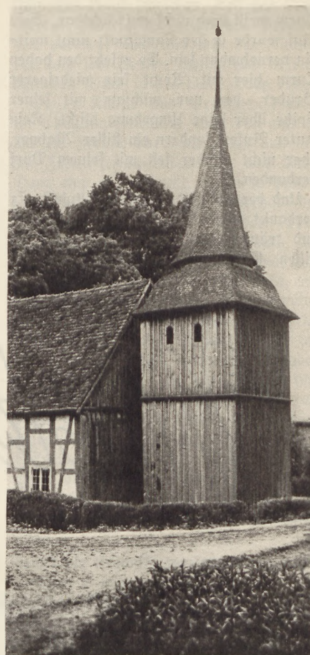
Seelow am Müritzer: Alter Holzturm mit gerader Wandung
