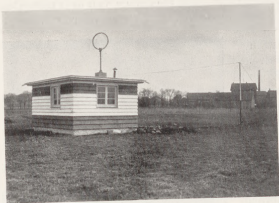
Fig. 19. Bodenpeilstelle.
