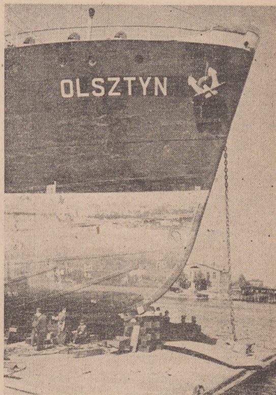
Praca przy opukiwaniu z rdzy podwodnej części kadłuba s/s „Olsztyn”
