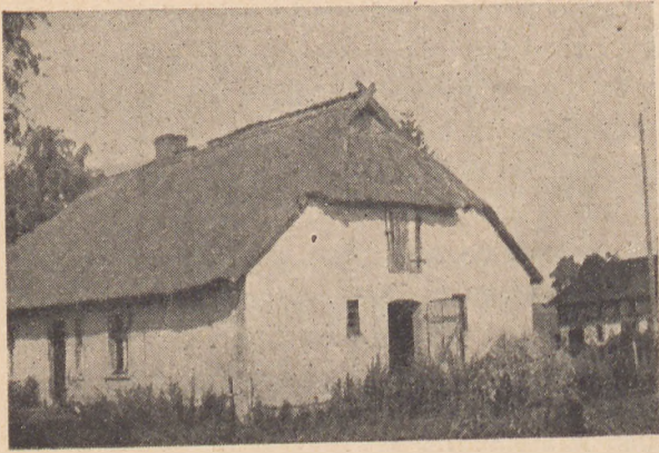
Ryc. 259. Smołdzino. Dom z dachem naczółkowym.
