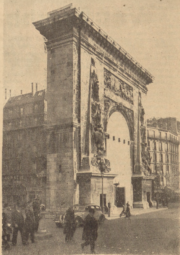
Brama St. Denis w Paryżu przy Wielkich Bulwarach. Zdjęcie pochodzi jeszcze z czasów wojny, kiedy to wszystkie nabytki sztuki, z uwagi na możliwość zniszczenia, zostały zabezpieczone przed skutkami bombardowania.
