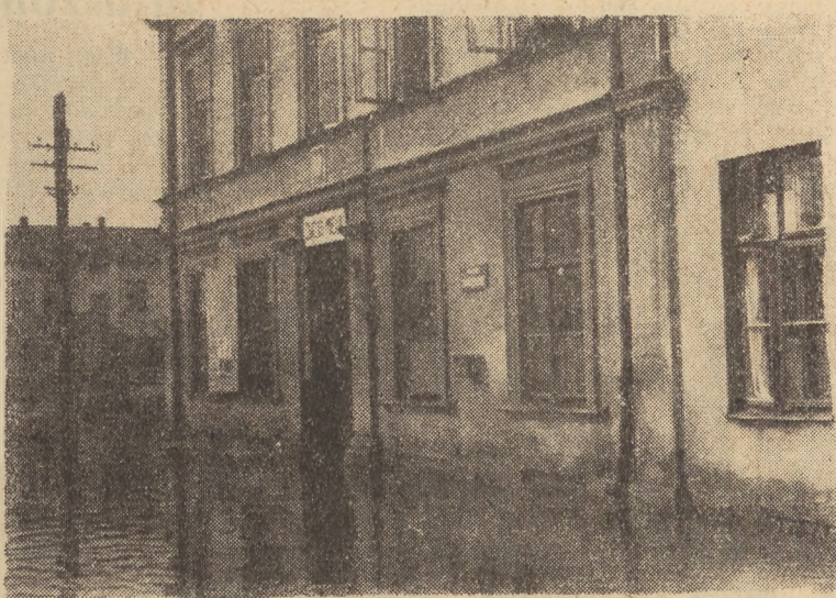
Dojście do magistratu w Nowym Dworze zalane wodą
