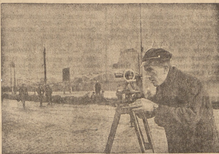
Student Wyższej Szkoły Inżynierii w Szczecinie wytycza kierunkowe dla wzbijania pali pod budowę mostu „boykowskiego” na Łasztowni
