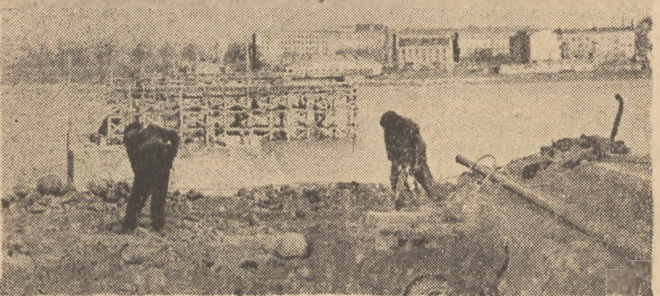
Przyczółek dawnego mostu Kierbedzia przygotowuje się na przyjęcie konstrukcji nowego mostu Śląsko-Dąbrowskiego
