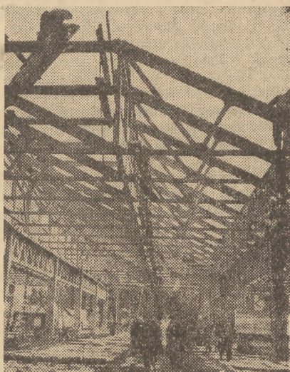
Ustawienie ostatniej kratownicy dachowej w hali mechanicznej fabryki samochodów na Żeraniu
