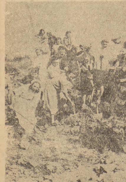
Personel szpitala KBW przy ul. Żelaznej 90 pracuje przy odbudowie szpitala.
