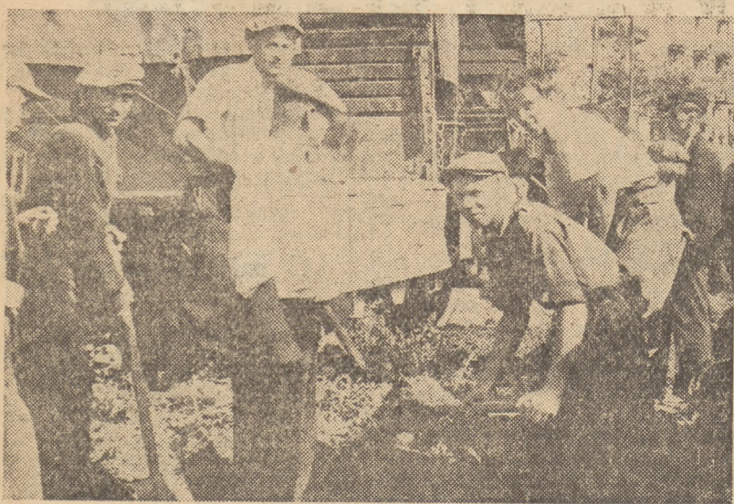
Pracownicy DOKP na Pradze oczyszczają swój teren z gruzu.
