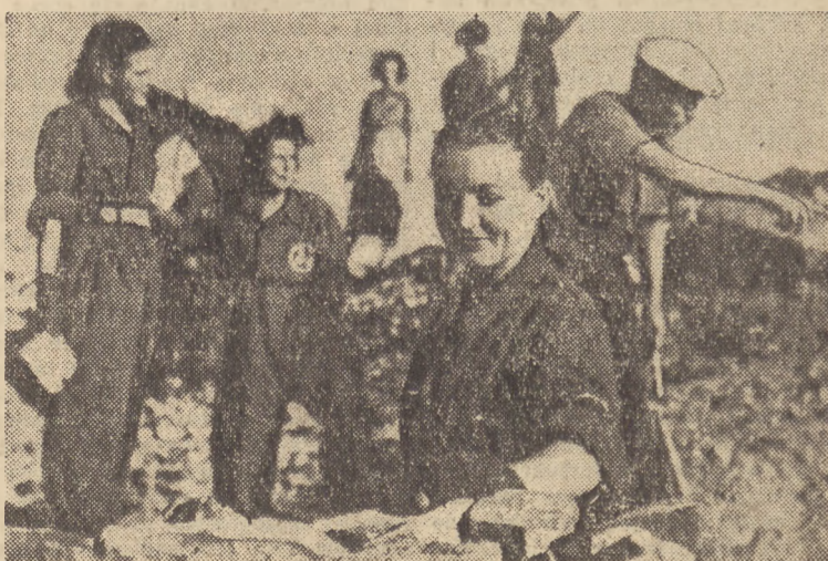
We wrześniu, miesiącu odbudowy stolicy ludność Warszawy bierze masowy udział w oczyszczaniu terenów pod budowę nowych domów, ulic i parków. Na zdjęciu grupa warszawianek uprząta zwaly gruzy na Muranowie. (foto API)
