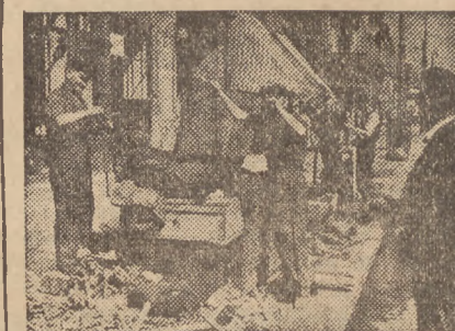
Prace przy odbudowie linii tramwajowych, idących z Mokotowa, w kierunku północnych dzielnic miasta i na uniknięcie kłopotliwych „prześladek” na Pl. Zbawiciela.
