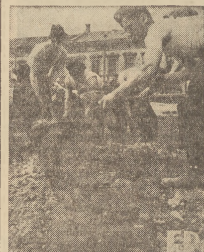
Ich kolezdy pracują pilnie przy poszerzeniu ul. Marszałkowskiej. Tym właśnie młodym chłopcom zawdzięczać będzie Warszawa jedną z najpiękniejszych ulic przyszłości
