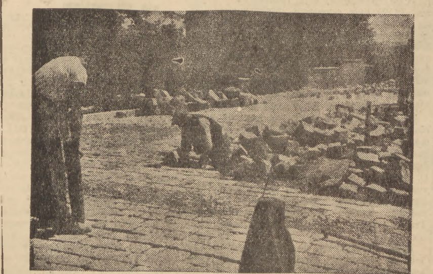
Robotnicy kończą pracę przy wykopie tunelu na rogu Smolnej
