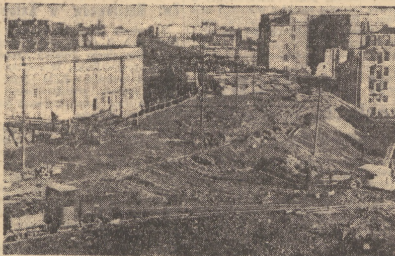
Tutaj już wyraźnie widać przyszłą arterię W-Z. Po lewej — Pałac pod Blachą, na wprost — oszalowanie wiaduktu.
