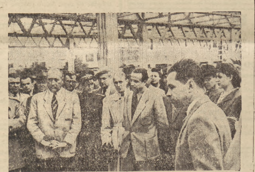
Budowa fabryki urządzeń radiowych przy ul. Karolkowej. Pokaz nowego systemu budownictwa, który polega na stosowaniu prefabrykatów wyrabianych na miejscu budowy.
