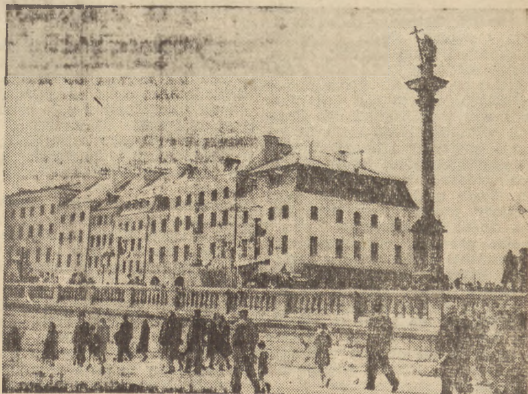
Co niedziela i święto na trasę W—Z ciągną grupy zwiedzających. Na zdjęciu fragment balustrady z płaskowca nad tunelem. Zabytkowe domy na płycie tunelu i kolumna, Zygmunt
