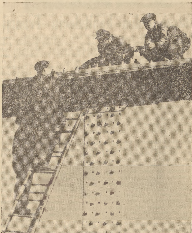
„Do 1 grudnia zmontujemy 4 prześia mostu Śląsko-Dąbrowskiego...” obiecali robotnicy „Mostostalu” odpowiadając na apel górników z Zabrze. I wzięli się ostro do roboty przy nitowaniu. (Fot. APH)
