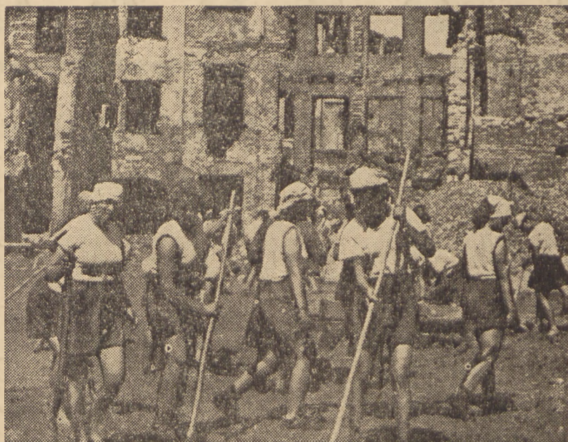
Przy robotach ziemnych na warszawskiej trasie W—Z wielką aktywność wykazują junaczki „Służby Polce”. Na zdjęciu widzimy je gdy wykonują roboty, związane z urządzeniem kwiatników ozdobiających trasę
