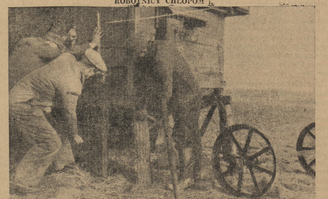
Robotnicy Państwowego Przedsiębiorstwa Budowlanego w godzinach wolnych od pracy remontują maszyny rolnicze Ośrodka Maszynowego w Łomiankach
