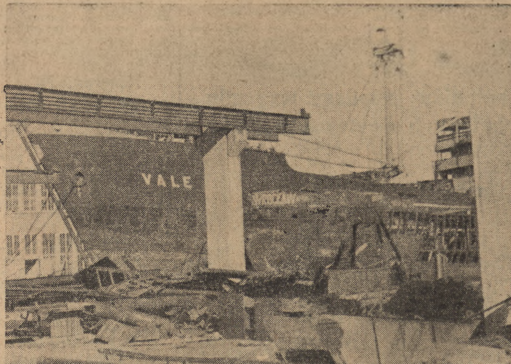
Stocznia w Gdyni pracuje bardzo intensywnie. Na fotografii dwa statki: radziecki „VA-LE” i polski „WROCLAW” w czasie remontu w tej stoczni
