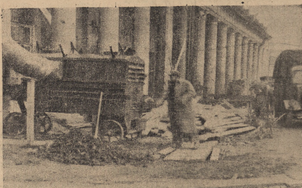
Mrozy nie wstrzymują prac przy odbudowie Teatru Narodowego w Warszawie. Specjalnie zainstalowane piece ogrzewają i osuszają wnętrze gmachu.
