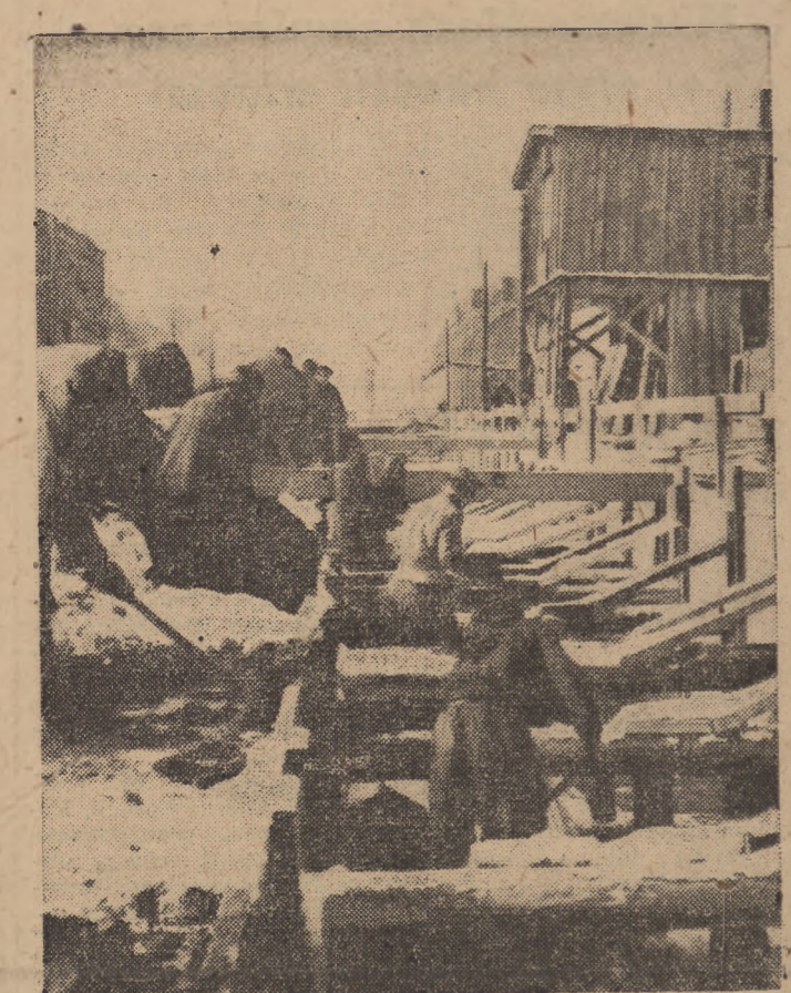
Śnieg i mrozy nie przerywają prac przy budowie ostatniego odcinka tunelu linii średnicowej, między ul. Bracką, a Marszałkowską
