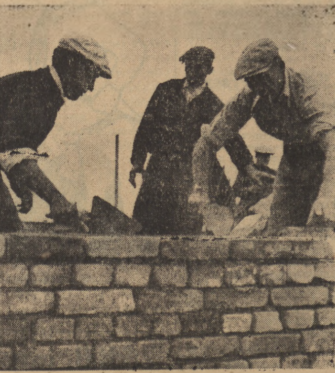
Tempo robót przy budowie domu szybkościowego na Mokotowie w Warszawie jest większe od tempa, zakreślonego harmonogramem. Jest to zasługa wszystkich robotników, pracujących przy tej budowie. Na fotografii murarz Jan Wit i jego pomocnik Ryszard Banasiak. Foto: AR
