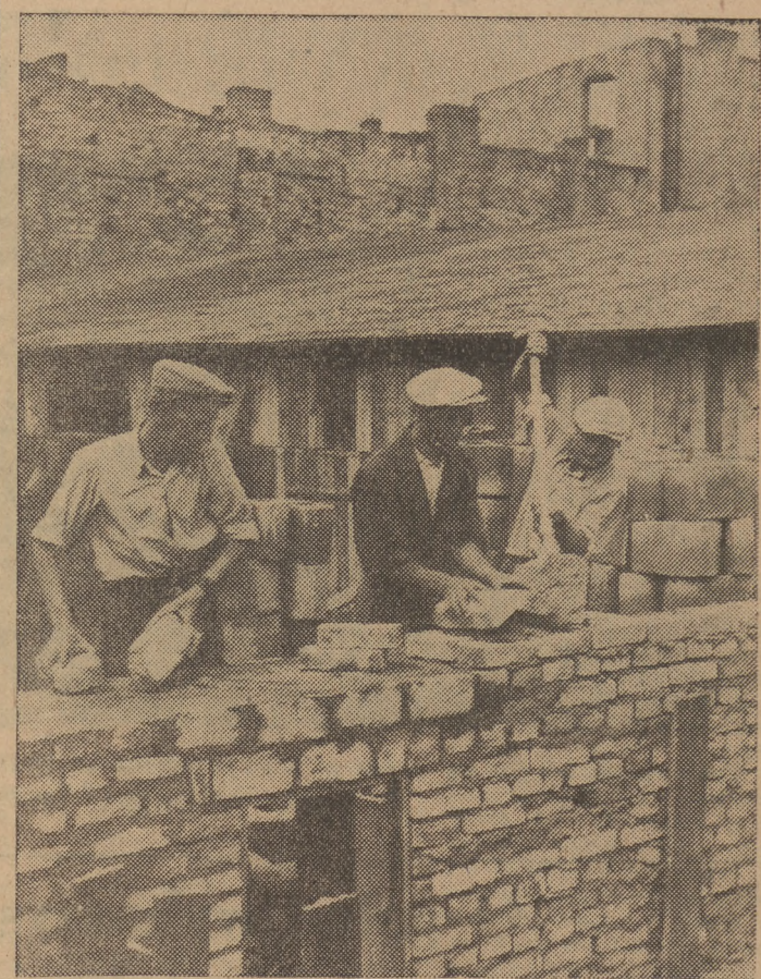
Trójka murarska Romana Królikowskiego, pracująca przy budowie osiedla na Młynowie uzyskała nowy rekord murowania na tzw. fiłkach. Trójka Królikowskiego ułożyła w ciągu ośmiu godzin pracy 15.771 cegieł, a więc o 5.500 cegieł więcej od poprzedniego rekordu.
