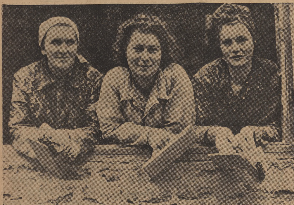
Kobieta trójka tynkarska, pracująca przy budowie osiedla ZOR na Młynowie w składzie (od lewej) Antonina Traczyk, Irena Kozioł i Kazimiera Wysocka ustanowiła rekord w tynkowaniu ścian osiągając 799 proc. normy.
