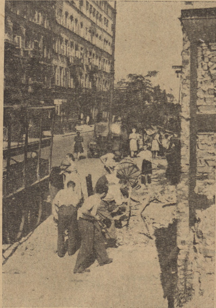
W ramach czynu lipcowego mieszkańcy Warszawy wzięli udział w akcji odgruzowania stolicy. Na fotografii: grupa pracowników Zarządu Głównego RSW „Prasa” przy oczyszczaniu ulicy.
