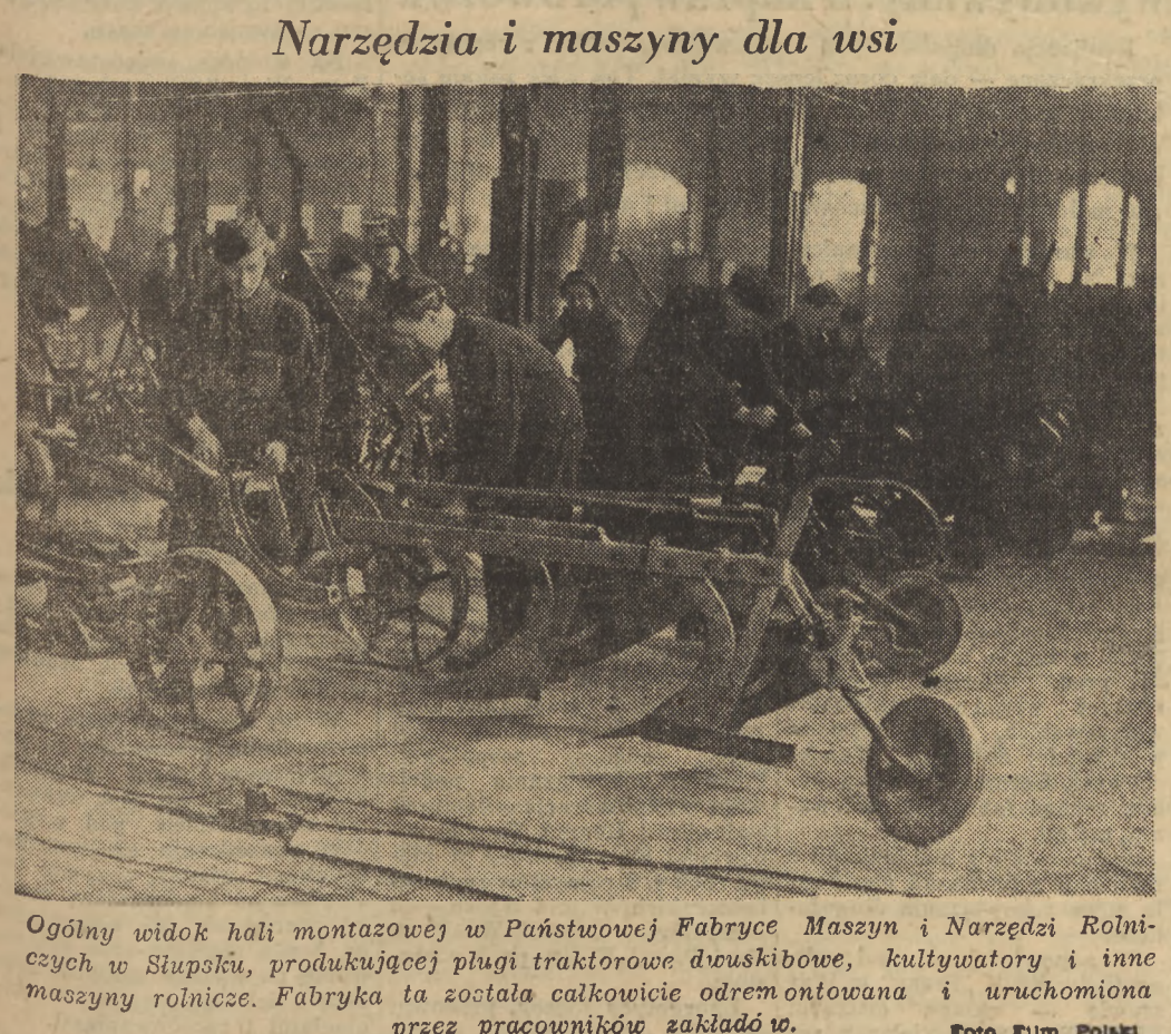
Ogólny widok hali montażowej w Państwowej Fabryce Maszyn i Narzędzi Rolniczych w Siłpsku, produkującej plugi traktorowe dwukółkowe, kultywatory i inne maszyny rolnicze. Fabryka ta została całkowicie odremontowana i uruchomiona przez pracowników zakładu w.
