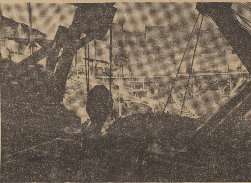
Budowa bloku 3a jednego z pierwszych bloków Marszałkowskiej Dzielnicy Mieszkaniowej postępuje szybko naprzód. Blok ten o wysokości 5 pięter stanowić będzie wschodnią ścianę przyszłego wielkiego placu śródmiejskiego stolicy.
