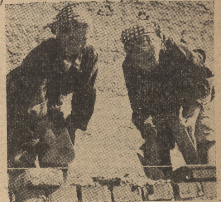
Coraz więcej kobiet pracuje w zawodach dostępnych dawniej tylko dla mężczyzn. Na budowie dzielnicowego domu PZPR przy skrzyżowaniu Trasy W-Z z ul. Nowomorska, dzielnie sekunduje w pracy murarzem młodzieżowa kobieca brigada murarska. Na zdjęciu murarki: Czesława Komorowska i Józefa Kozłowska przy pracy.
