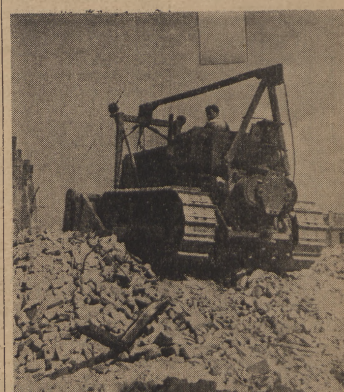
Prace przygotowawcze do budowy Marszałkowskiej Dzielnicy Mieszkaniowej postępują w szybkim tempie naprzód. Na zdjęciu spychacz „Staliniec” produkcyj radzieckiej w czasie usuwania gruzu. Foto Film Polski
