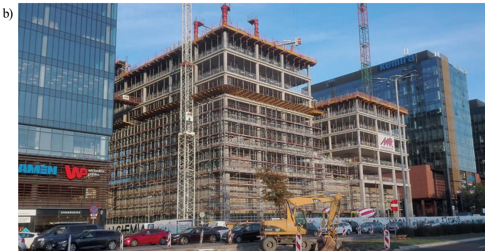
Rys. 2.13. Przykładowe zastosowania żelbetowych słupów o przekroju kołowym w obiektach budowlanych w Gdańsku: a) wiadukt zbudowany w 1970 roku w ciągu ulicy Błędnik – stan obecny; b) budowa biurowca w wielofunkcyjnym kompleksie biznesowym Alchemia, rok 2018. Fot. autor
