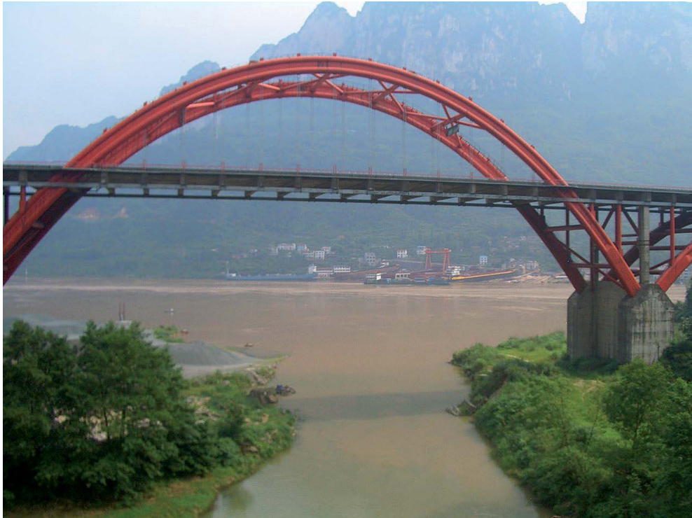
Rys. 2.15. Most łukowy Liantuo w Chinach o dźwigarach typu CFST.
