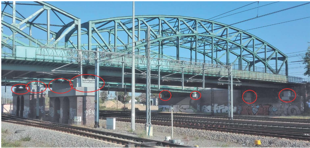
Rys. 2.17. Wiadukty stalowe w Gdańsku nad torami kolejowymi w ciągu ulicy Kościuszki: stary (obecnie około stuletni, na pierwszym planie) i nowy (obecnie kilkuletni, w tle) wsparte na wysokich żelbetowych ciosach podłożyskowych. Fot. autor
