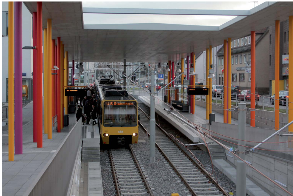
Rys. 2.18. Przykład potencjalnego zastosowania słupów CFFT dla osiągnięcia efektów architektonicznych. Fot. M. Frey, za zgodą z http://www.bahnbilder.de/bild/deutschland~stadtbahnen-und-u-bahnen~stadtbahn-stuttgart-haltestellen-und-strecken/563125/-bunte-stuetzen---die-neue.html
