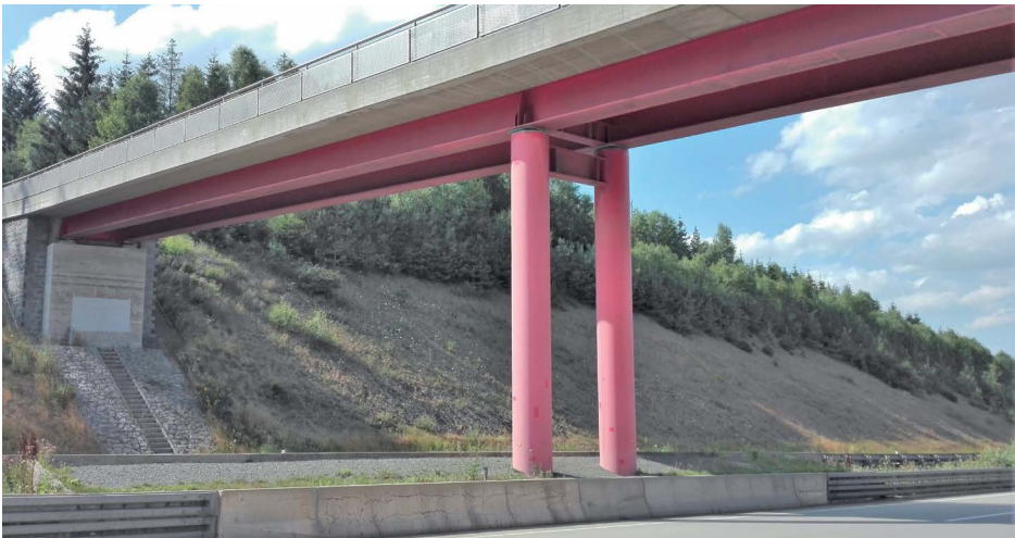
Rys. 2.14. Słupy o kołowym przekroju poprzecznym wspierające wiadukty drogowe nad autostradami: a) wiadukt betonowy nad Autostradą Wolności (A2) na odcinku Września–Torzym; b) wiadukt zespolony stalowo-betonowy nad Autostradą A93 w Niemczech, na odcinku Regensburg–Hof. Stan z 2018 roku. Fot. autor
