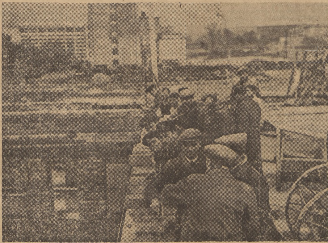
W Warszawie na budowie przy ulicy Skłerniewickiej na Wol., zakończył się w sobotę trzydniowy praktyczny pokaz pracy zespołowej systemem długim w tym dla robotników budowlanych, słuchaczy kursu instruktorów stachanowskich metod pracy w budownictwie. Na zdjęciu: jeden z wykładowców Ministerstwa Budownictwa, Przemysłowego wyjaśnia przy- szłym instruktorom metodę pracy systemem stachanowskim. Foto CAF
